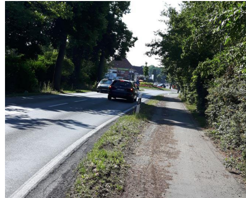
Friedrichsdorfer Str.: Rad- und Fußweg hinter der Kurve, Blickrichtung Kreisverkehr
